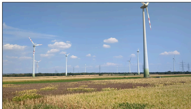
Les rotors d'une longueur d'environ 80 mètres, devenus courants aujourd'hui, ont une surface totale de 250 à 350 mètres carrés. Une installation éolienne avec trois rotors de ce type a donc une surface totale d'environ 1000 mètres carrés. (Photo mad)
